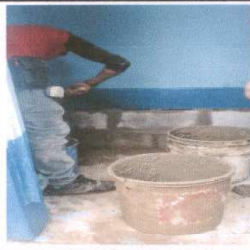
Foto 4: Cambio de baños
