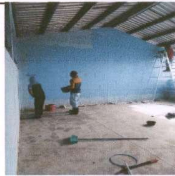
Foto 6: Trabajo de pintura
