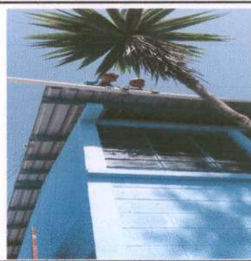
Foto 2: Cambio de canales por deterioro
